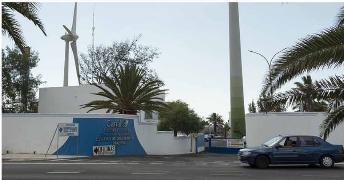
Central de desalación Díaz Rijo.
